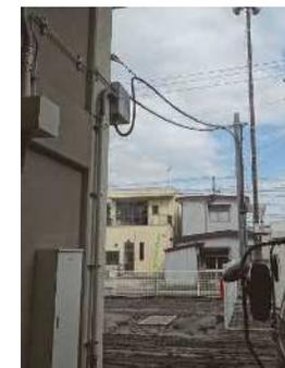
高圧受変電設備が利用できないため、校外の電線より低圧電力を引き込み、仮設電源として利用
