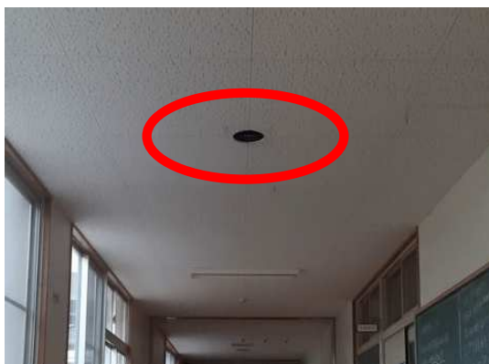
スピーカーが設置されていた天井
