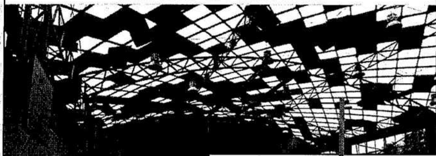
屋内運動場屋根ふき材等の飛散
