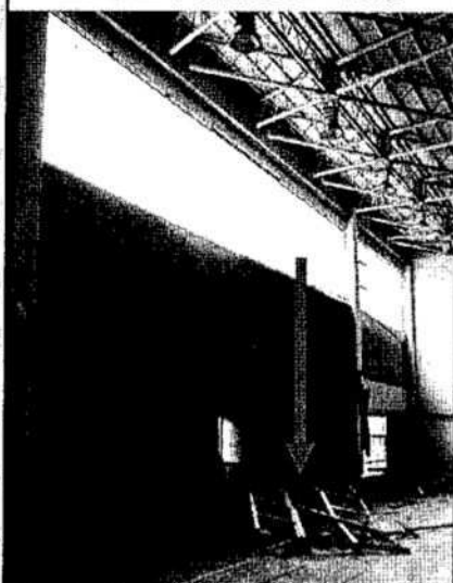
屋内運動場横連窓の脱落
