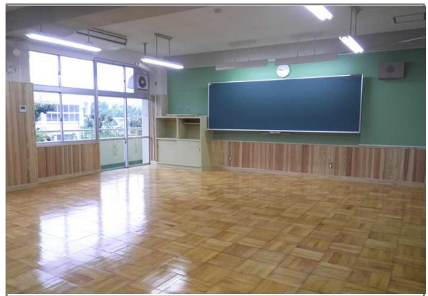
写真② 校舎内観（普通教室前方） 壁には県産材の杉材を使用。床は既存のフローリングブロックを研磨補修した。
