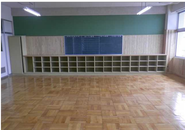
写真③ 校舎内観（普通教室後方） 背面黑板の周りの掲示板部分にも県産材の杉材を貼った。
