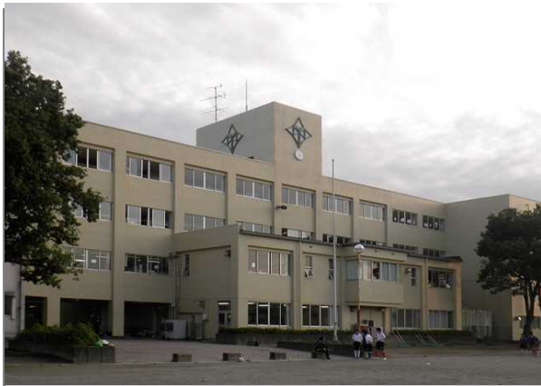
写真① 改造後の校舎外観 管理教室棟と特別教室棟の壁面の補修、外装塗装、防水改修を行った。
