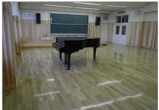
写真④ 校舎内観（特別教室棟・音楽室） 壁には県産材の杉材を、床の全面改修には国産材のブナフローリングブロックを使用した。
