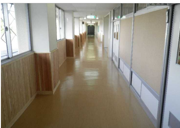
写真⑤ 校舎内観（渡り廊下） 窓側壁の木質化に合わせ、教室側掲示板部分はコルク地、床は木目調シートとした。
