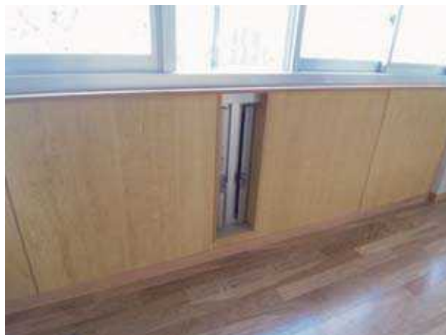
写真9 (上) 階段室上部の自動開閉装置付き排気用窓 (左下) 給気用窓 (下) 給気用スリット
