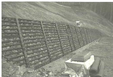
鋼製枠工
