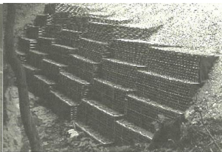
大型かご枠工
