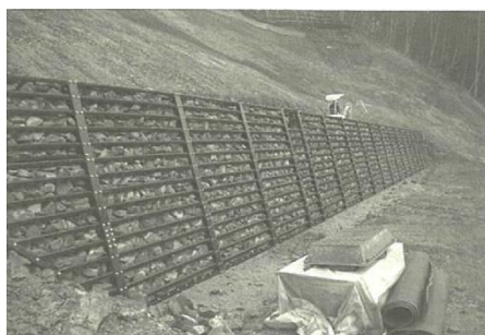
鋼製枠工
