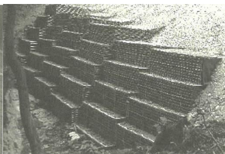
大型かご枠工
