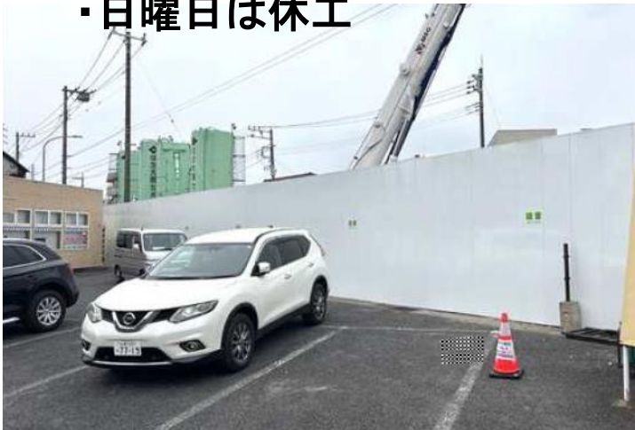
写真. 防音パネル設置状況
