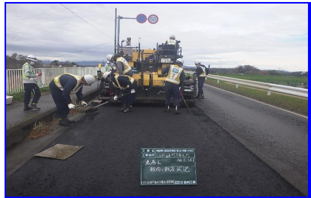
施工中 (合材敷均し)
