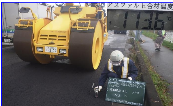
施工中 (初期転圧温度測定 113.6℃)
