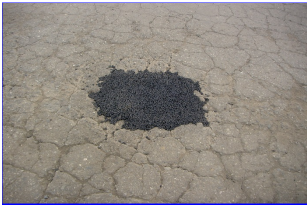
ポットホールの補修
