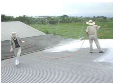
石灰の吹き付け（宮崎県）
