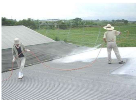
石灰の吹き付け（宮崎県）
