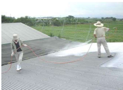
石灰の吹き付け（宮崎県）
