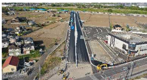
県道中井松伏線田島(南)交差点付近
