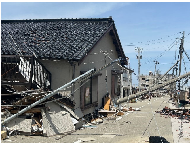
令和6年能登半島地震(珠洲市)
