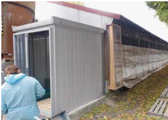
前室（物置倉庫）設置事例
