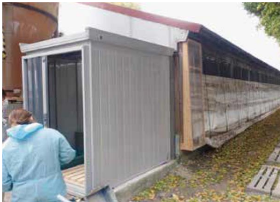
前室（物置倉庫）設置事例
