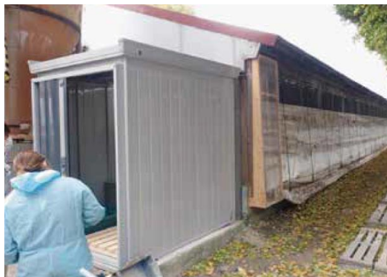
前室（物置倉庫）設置事例
