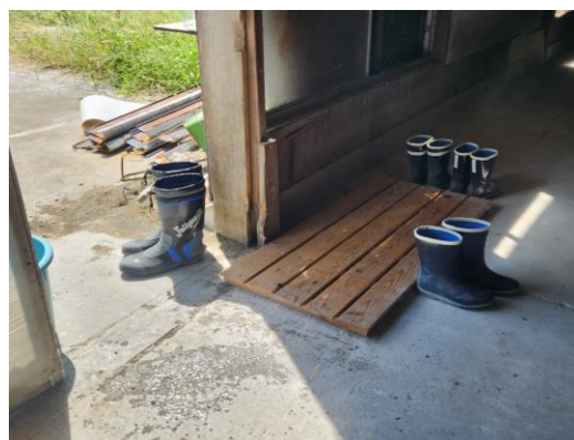
スノコ設置事例（交差汚染防止）
