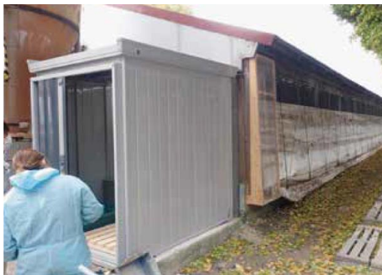
前室（物置倉庫）設置事例
