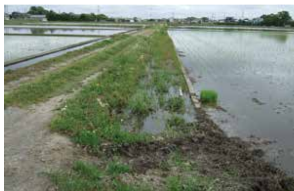
▲地区内の未整備水路および農道
