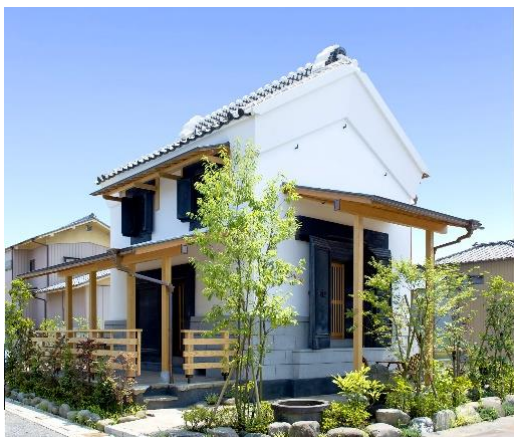
全景（修理しゅん工時）
