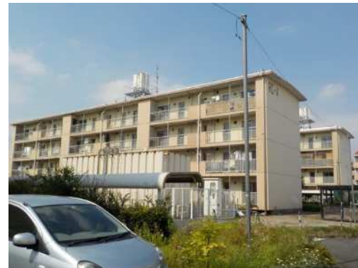
建替え予定の建物
