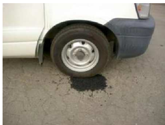
② 車で転圧して施工完了!!
