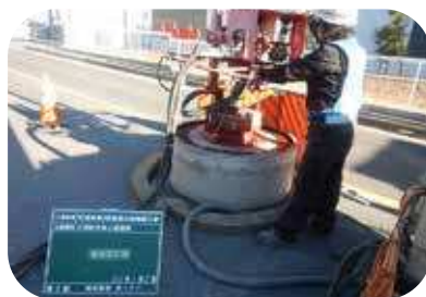
円形カッター舗装版切断
