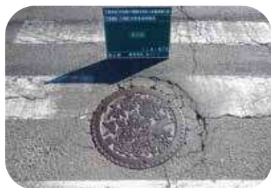
舗装版切断前
