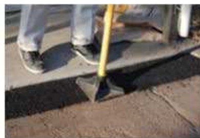
上から転圧します
