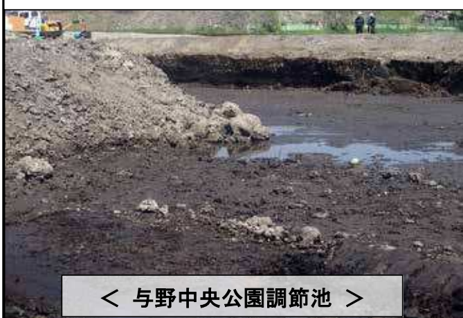
総Ⅰ除 交付金(河川)工事(与野中央公園調節池護岸工その1)
