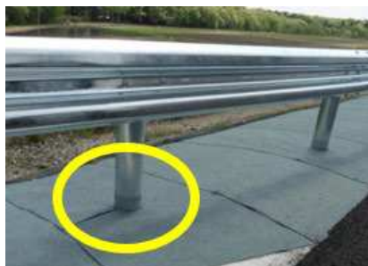
ガードレール支柱地際防食
