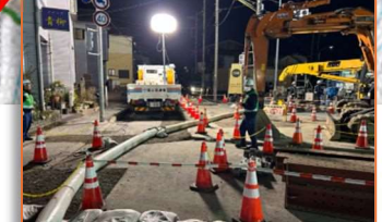
チュウ4からチュウ3へポンプ車による汚水移送
