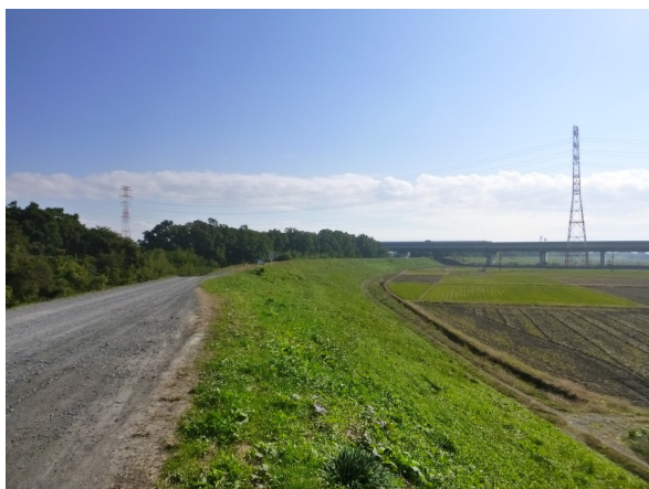
土手の状況 (圏央道方向)
