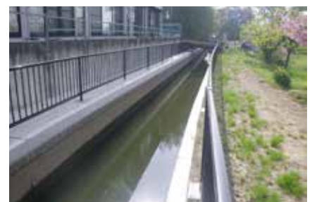
▲工事後の用水路
