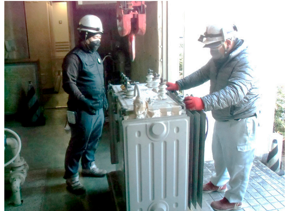
写真2-3 PCB廃棄物（PCB含有変圧器の運搬処理）
