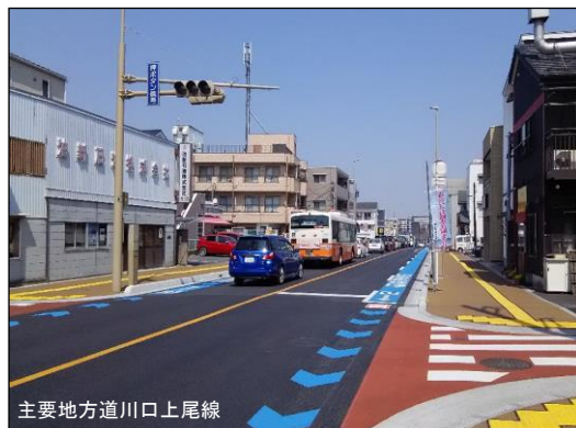
無電柱化完了後状況
