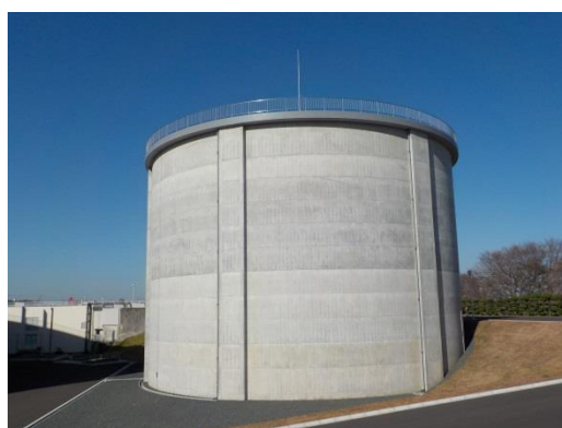
庄和浄水場PC浄水池 施工完了 全景(外観)
