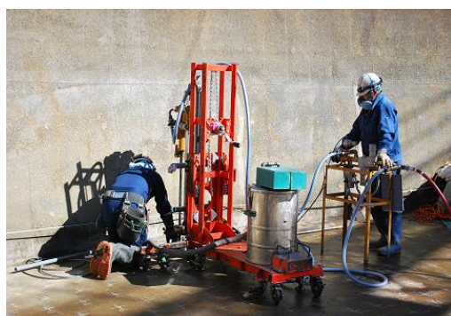
水道施設耐震補強 施工状況 (大久保浄水場汚泥調整池)
