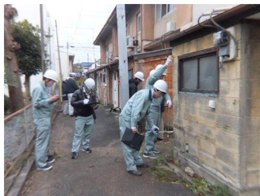
応急危険度判定模擬訓練
