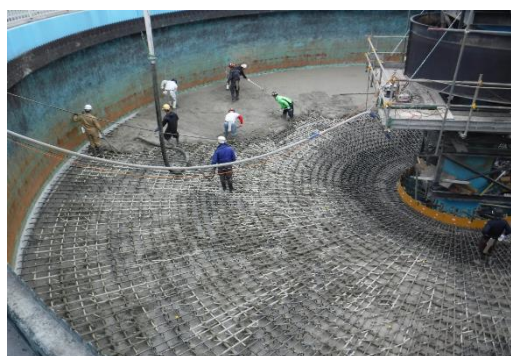
水道施設耐震補強 施工状況 (吉見浄水場濃縮槽)
