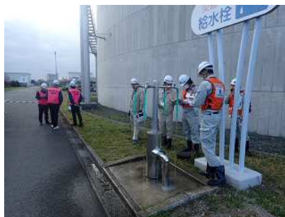
(災害時給水栓の確認)
