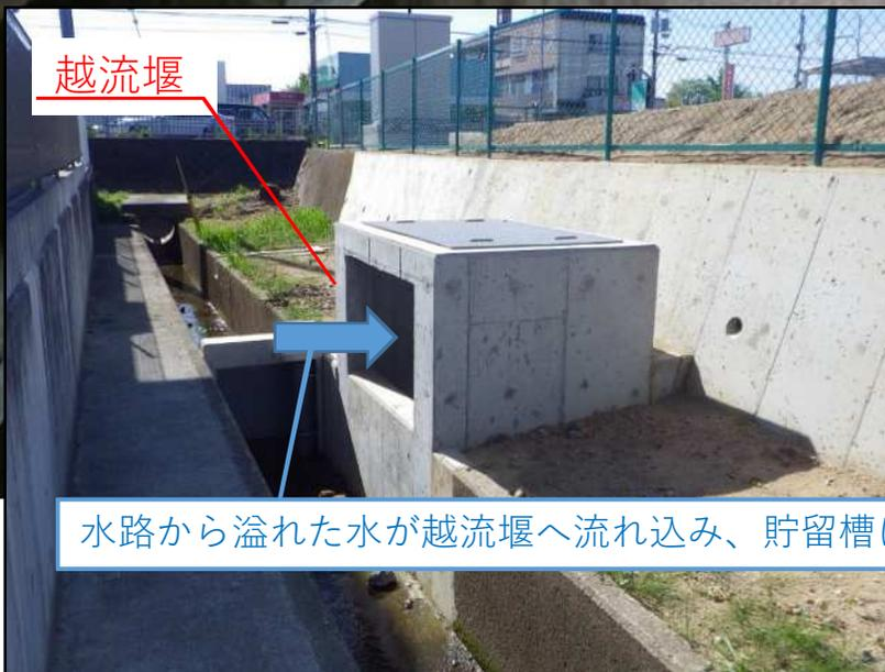
水路から溢れた水が越流堰へ流れ込み、貯留槽に流入。
