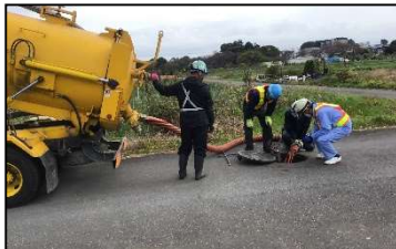
吸引車による汚水の移送(管路協)
