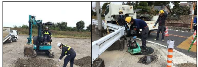
仮設沈殿池掘削・人孔補修(建設協)
