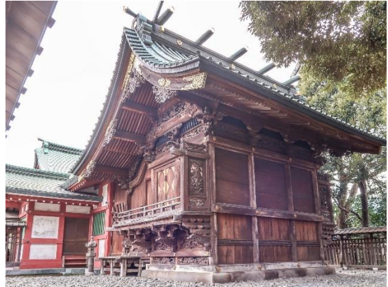
本殿（東側面と北面）
