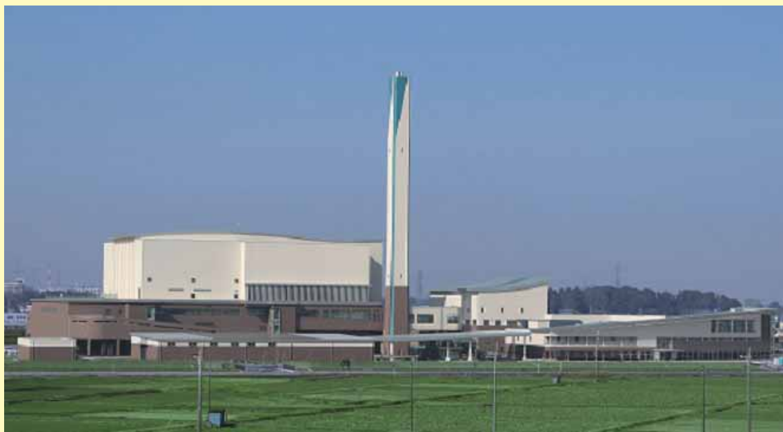
川越市資源化センター
