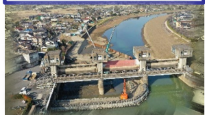
農業水利施設の耐震補強の前倒し
