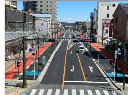
無電柱化の整備箇所 (都) 駅前東通線 (東松山市)
