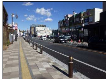
無電柱化の整備箇所 (都) 中央通線 (秩父市)
