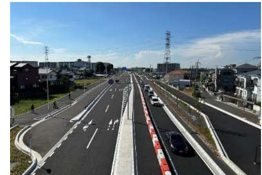
整備状況 国道254号（和光富士見バイパス）
