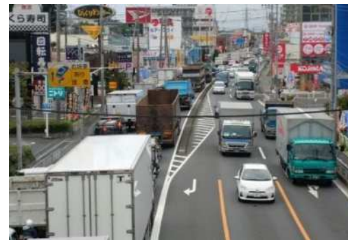
現道の渋滞状況 国道254号（新座市内）
