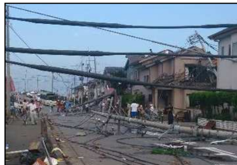
突風による電柱倒壊 (越谷市)
