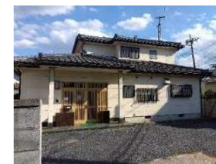
整備したグループホーム
