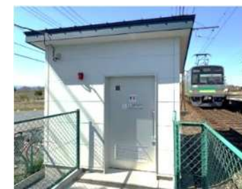
障害者対応型トイレ
