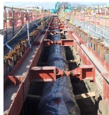
写真 送水管の布設状況
