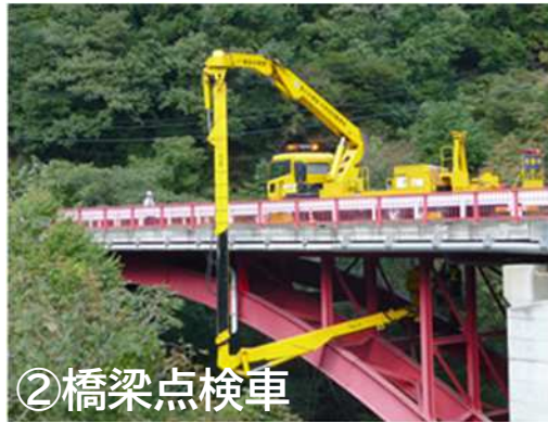
橋りょう点検
