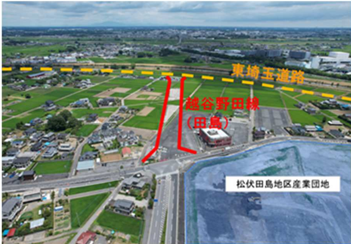
整備実施箇所例 越谷野田線(田島)
