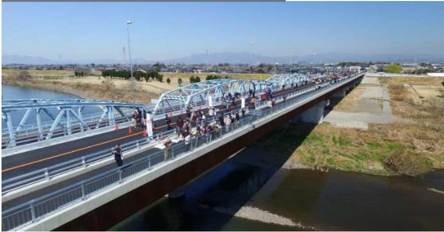
伊勢崎深谷線(上武大橋)
