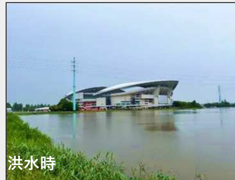
大門上池調節池 (埼玉スタジアム2002)
