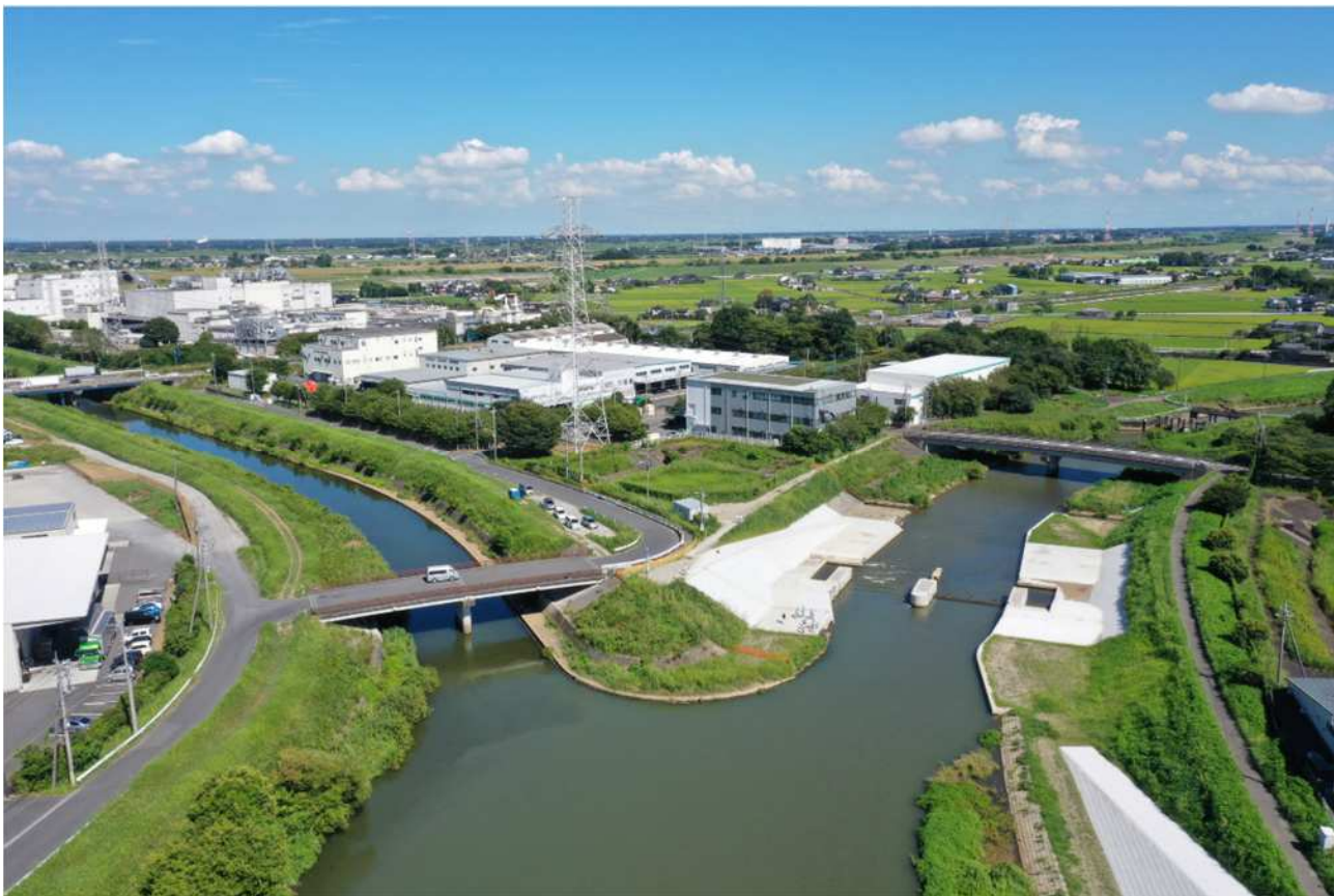
宇和田さくら堰 (左) 幸手放水路、(右) 中川 (幸手市)
