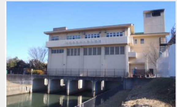
辰井川排水機場/辰井川 (草加市)
