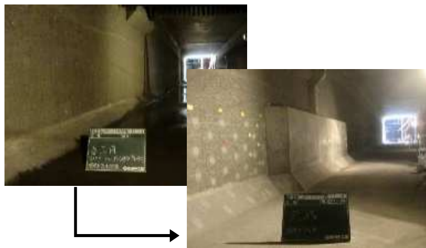
水処理施設等耐震化工事 (床コンクリートの増厚)
