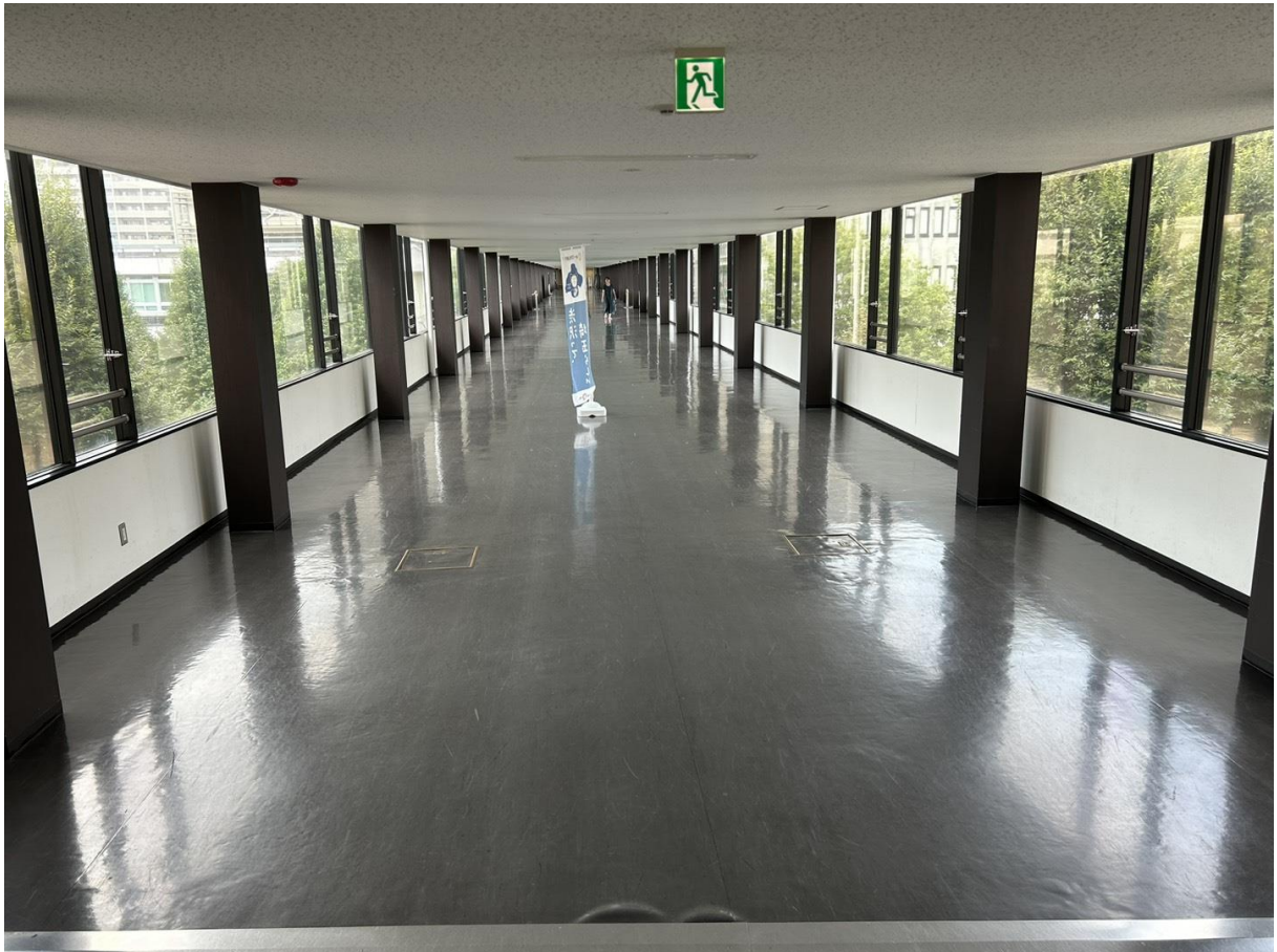
渡り廊下（本庁舎～第2庁舎間）①
