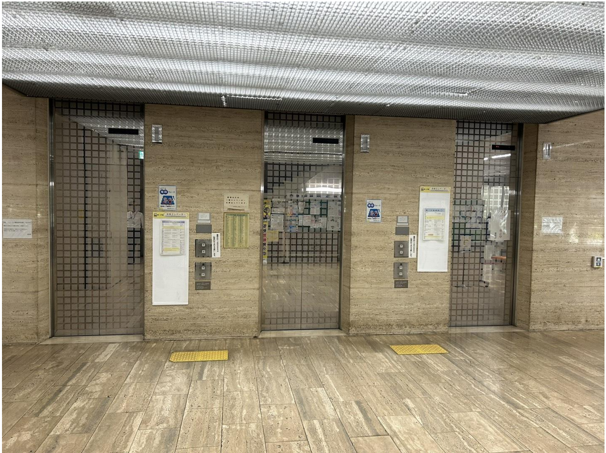
第2庁舎1階 中央エレベーター
