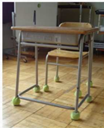
先生の話している声が聞き取りやすいように、机や椅子の脚にテニスボールを取り付けた
