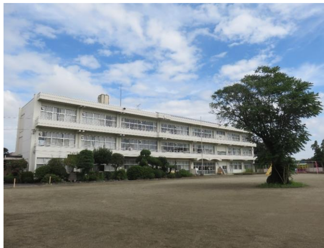
校舎 (鉄筋コンクリート造) 昭和51年3月建
