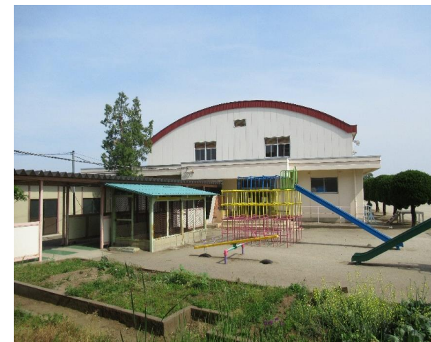
体育館 (鉄骨造) 昭和54年2月建
