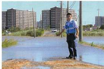
台風19号による被害で冠水した見沼区宮ヶ谷塔2丁目の市道の現場を視察(2019年10月13日午前)
