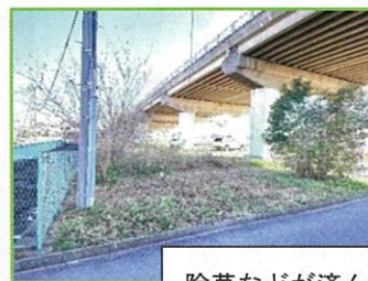
除草などが済んだ国道125号高架下
