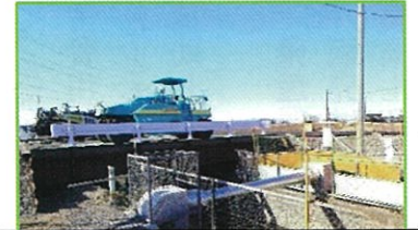
「県道上尾久喜線」のう回路整備
