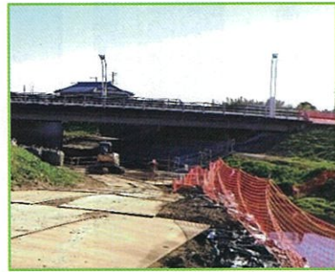
耐震化を進める「星川大橋」
