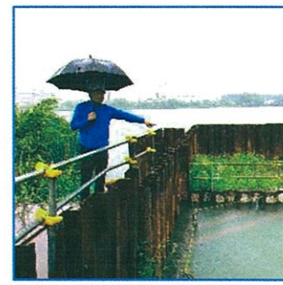
6月22日「庄兵衛堀川治水対策工事」現場視察を行いました。
