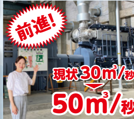
排水機場のポンプ能力向上へ
