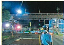
新設歩道橋架設
