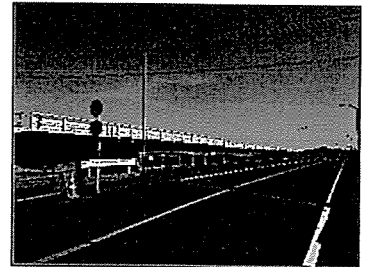
仮橋が完成した「島川橋」
