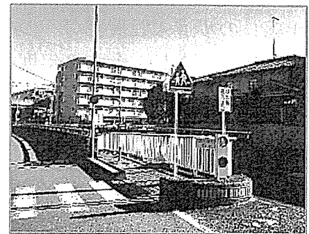
車道左側から移設した標識
